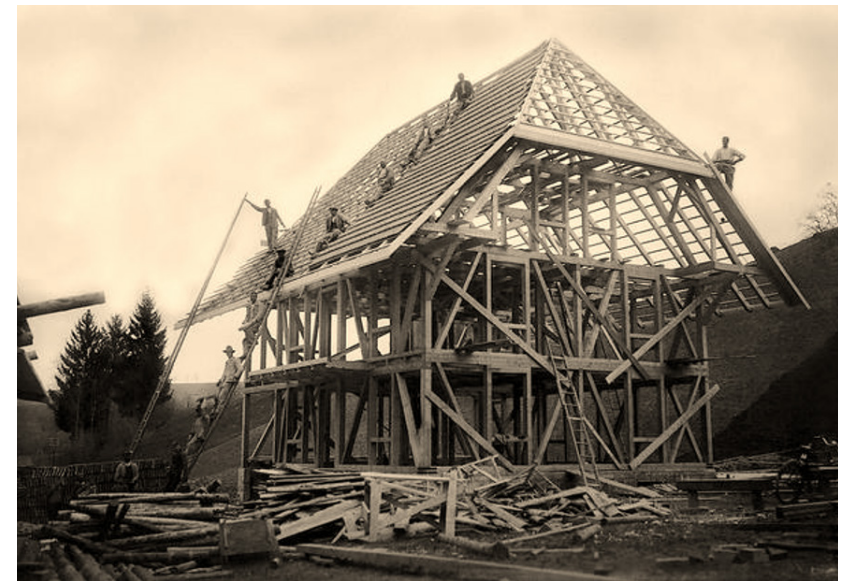
Chantier d'une maison en bois dans l'Emmental, vers 1930 (Bibliothèque nationale suisse, Berne, Archives fédérales des monuments historiques, fonds Ernst Hiltbrunner)
